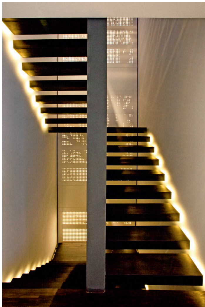
/ Leicht und transparent wirken die an einer Mittelwange aus Stahl befestigten Stufen in Räumereiche, in deren Stirnenden LED-Leuchten eingelassen sind – das Lochraster in der Rückwand erinnert an einen Baum, der hier ursprünglich stand.
