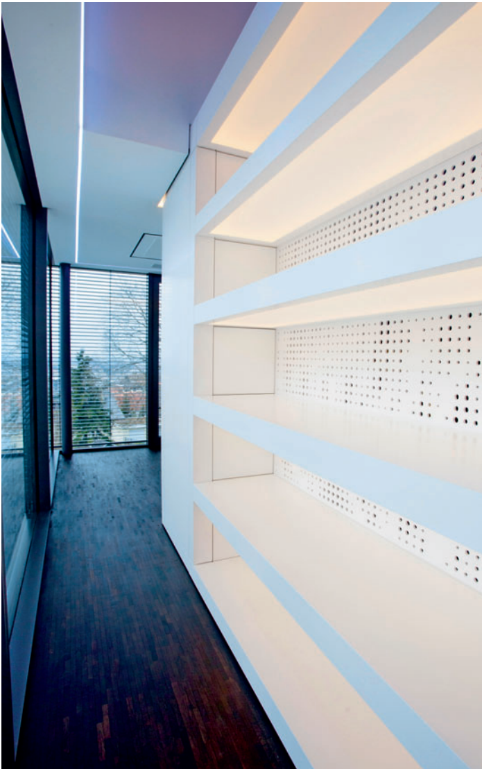
/ Ein Bohrbild gleich einem Lochstreifen aus der frühen Zeit der Datenverarbeitung lässt Licht ins Treppenhaus – starke, frei gespannte Böden dienen als Bücherregale.
