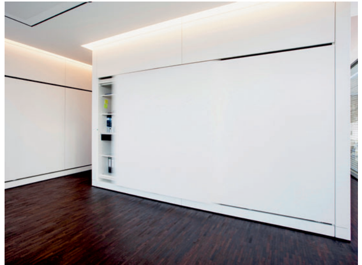
/ Groß, größer, am größten – zwei Aktenschränke werden durch gut 2 m breite, elektrisch angetriebene und flächenbündig laufende Schiebetüren verschlossen.
